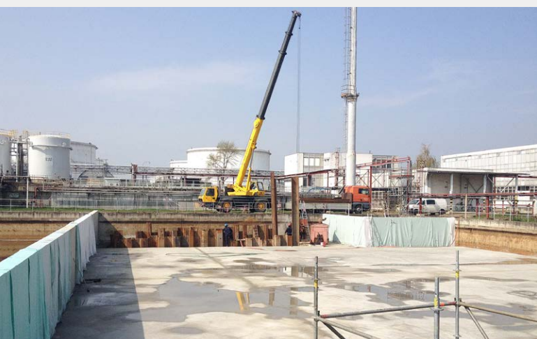
▲ Dělicí stěna pod vodou, suchá jímka pro výstavbu biologického stupně
