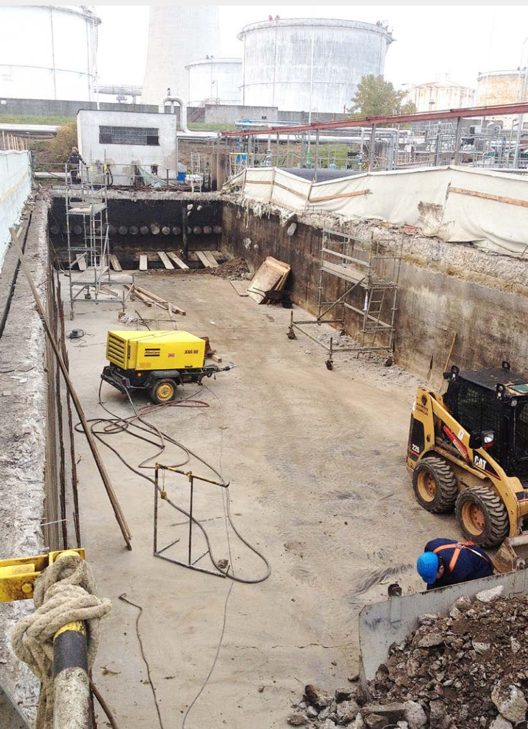
▼ Sanace usazovacích nádrží – 1. stupeň – primární sedimentace
