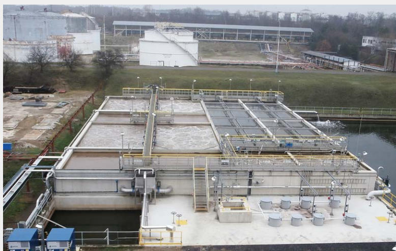
▼ Třetí stupeň – biologické čištění a 4. stupeň – koalescenční odlučovače
