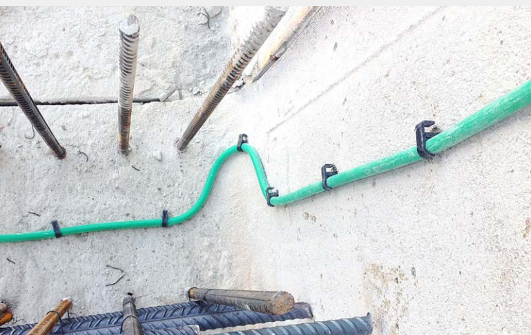
▲ Detail injektážní hadičky dělicí stěny
