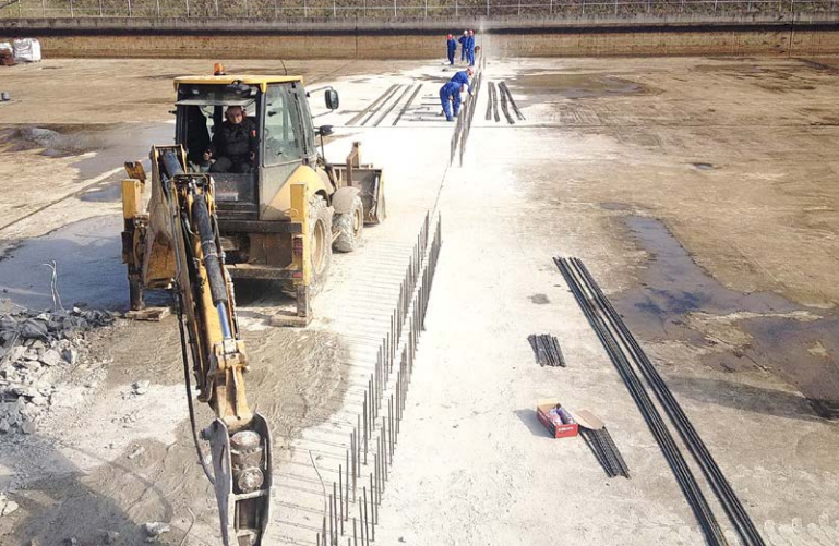
▲ Obr. 10. Výstavba dělicí stěny v biologickém rybníku
