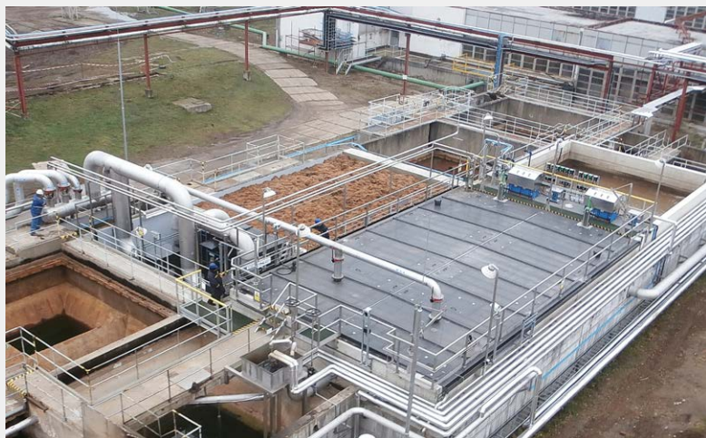
▲ Druhý stupeň – chemické čištění (koagulace, flokulace, separace v lamelových nádržích) a biofiltr s předřazenou vodní pračkou vzduchu
