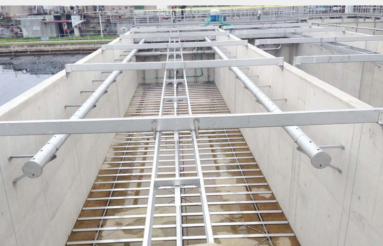
▼ Dokončování biologického stupně
