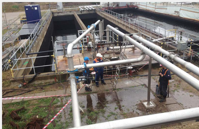
▲ Provizorní převod vody přes 2. stupeň
