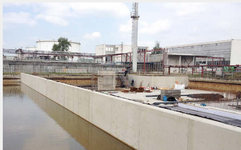
▲ Výstavba biologického stupně
