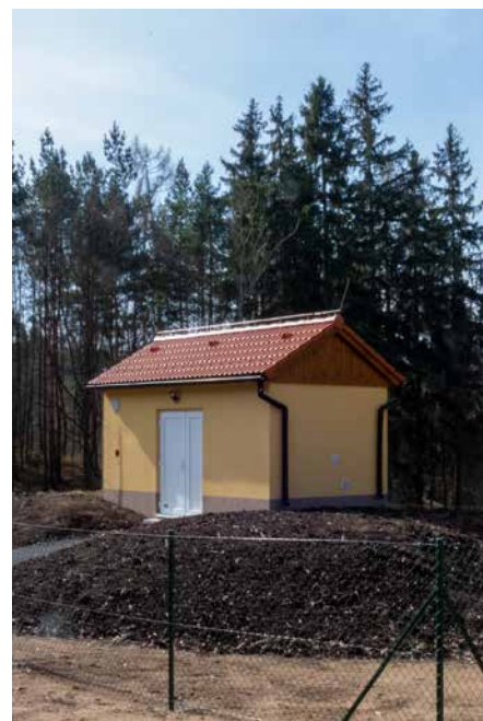
▲ Obr. 2 Vodojem Jelence, finální stav
