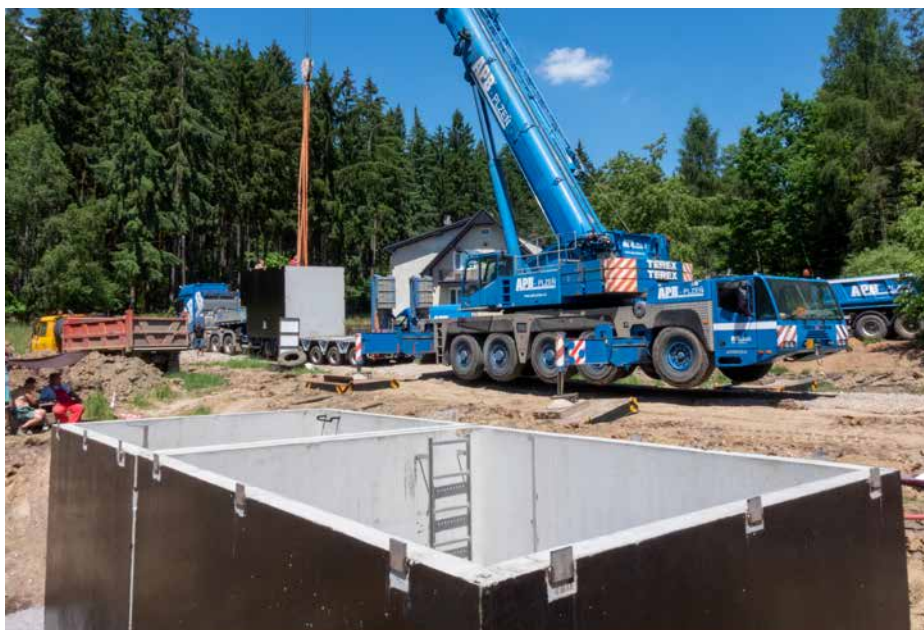
▲ Obr. 1 Montáž vodojemu 2x20 m 3 v obci Jelence, okres Příbram
